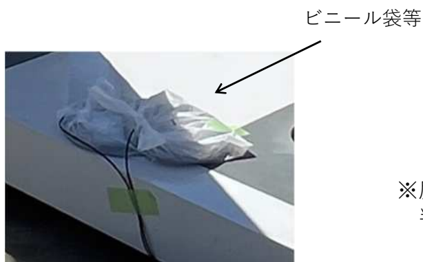
尻手先端の養生（例）
