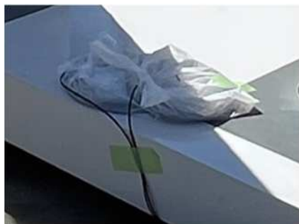
尻手側の養生
